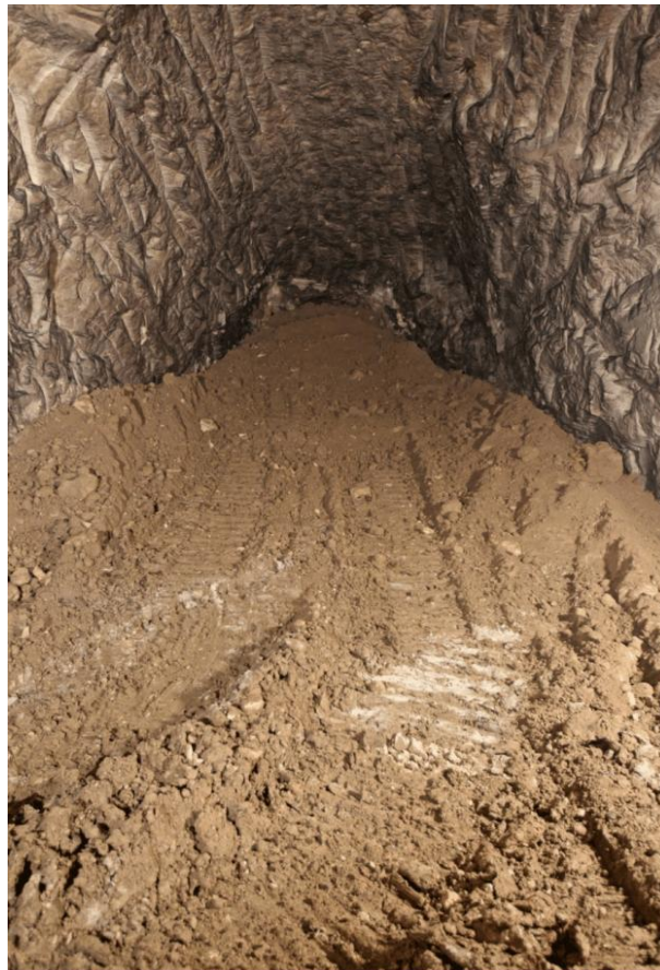
10) Remblayage total des galeries (carrière de Montmorency)
