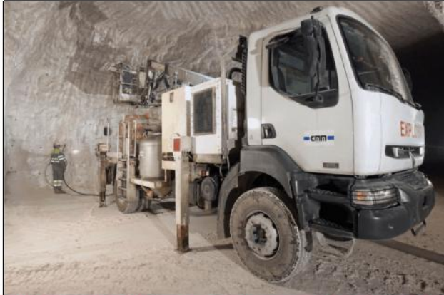
3) Chargement de l'explosif : camion avec nacelle et dispositif de chargement pneumatique (au cours d'une étape de traçage – carrière de Vaujours)
